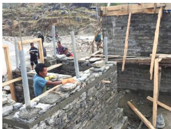
Construction d'une maison modèle dans la vallée de Thangpal Crédit photo : Fondation de France
