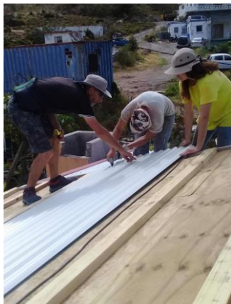
Des artisans réparant un toit à Saint-Martin © Compagnons Bâisseurs
