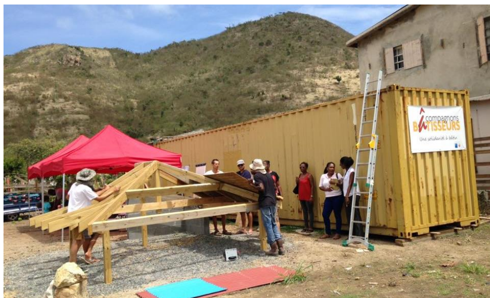
Une séance de formation à la réparation des toitures pour les habitants du Quartier-d'Orléans. © Compagnons Bâtisseurs
