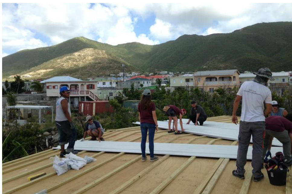
Des Compagnons Bâtisseurs finalisant la réparation d'un toit - © Compagnons Bâtisseurs mai 2018
